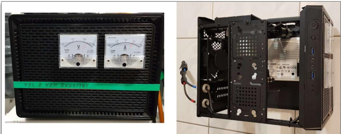
Bei unserer Erstinstallation haben wir ein Kompaktgerät mit einem 480 W Gleichrichter und der Schutzart IP20 für Innenräume verwendet. Eine temperaturgesteuerter Lüftung garantiert die Verwendung unter Dauerlast bis zu 3 eingebauten Gleichrichtern. Platziert ist das AP-Gehäuse auf der Wärmepumpe im Technikraum neben dem Zählerverteiler und der Notstrom Umschaltbox. Zusätzlich besitzt das Kompaktgerät noch 2 USB A Anschlüsse zum Laden für Notfälle.
