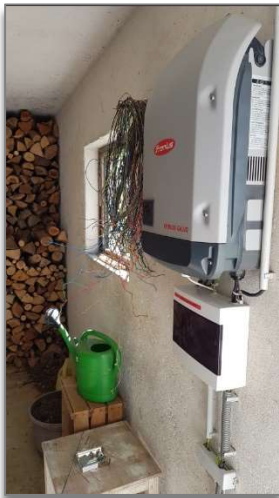
2 WR im Nebengebäude
